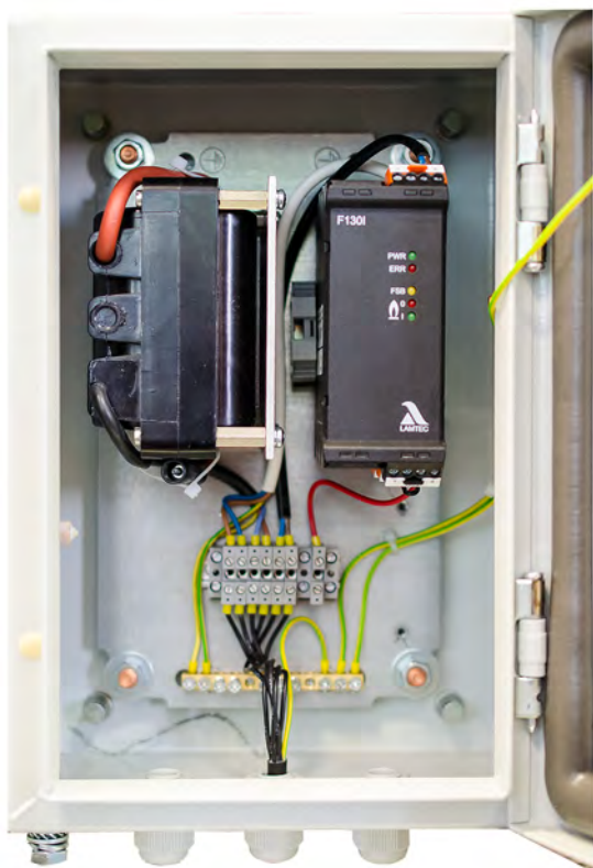
Fig. 3-31 Unité de puissance externe plage de sécurité
